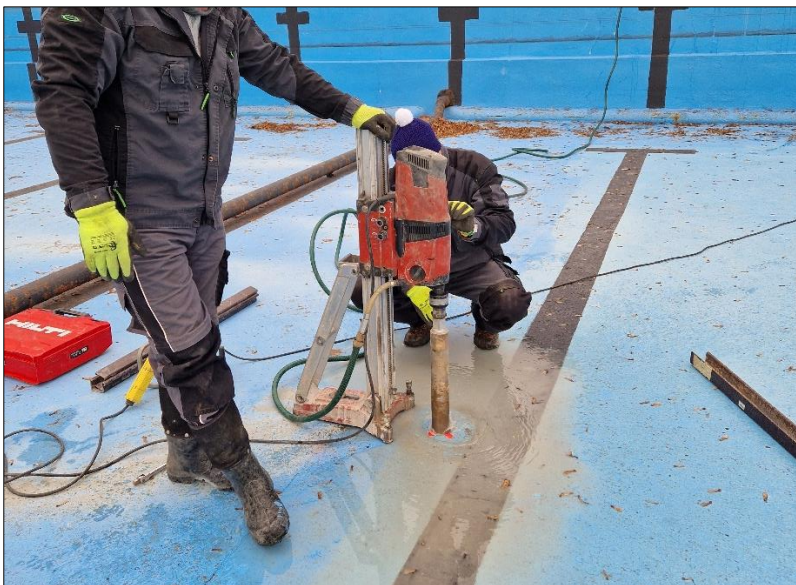
Obrázek 2: Vrtné práce ve dně bazénu – vrty V-4
